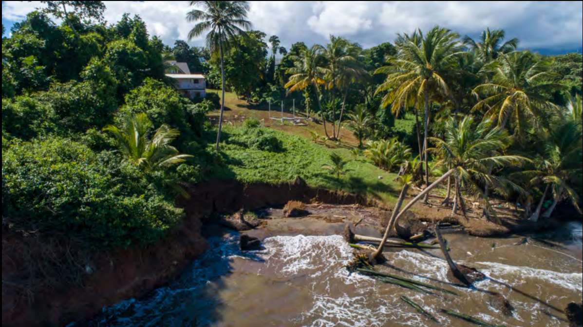
Erosion côtière - Guadeloupe - Décembre 2020
