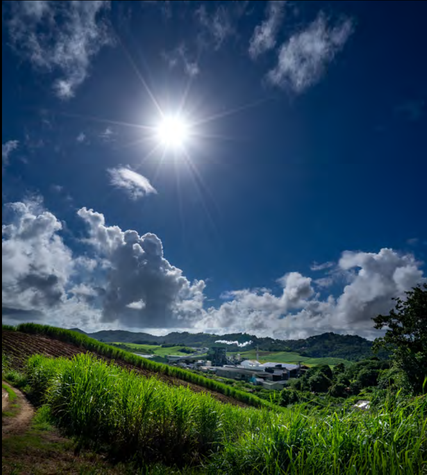
Usine de biomasse - Martinique- Décembre 2020
